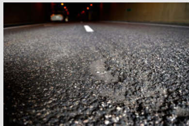
Revêtement goudronné d'une chaussée contenant de l'amiante
