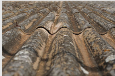
Toiture amiantée en fibrociment
