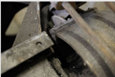
Mâchoires de frein d'un moteur d'ascenseur
